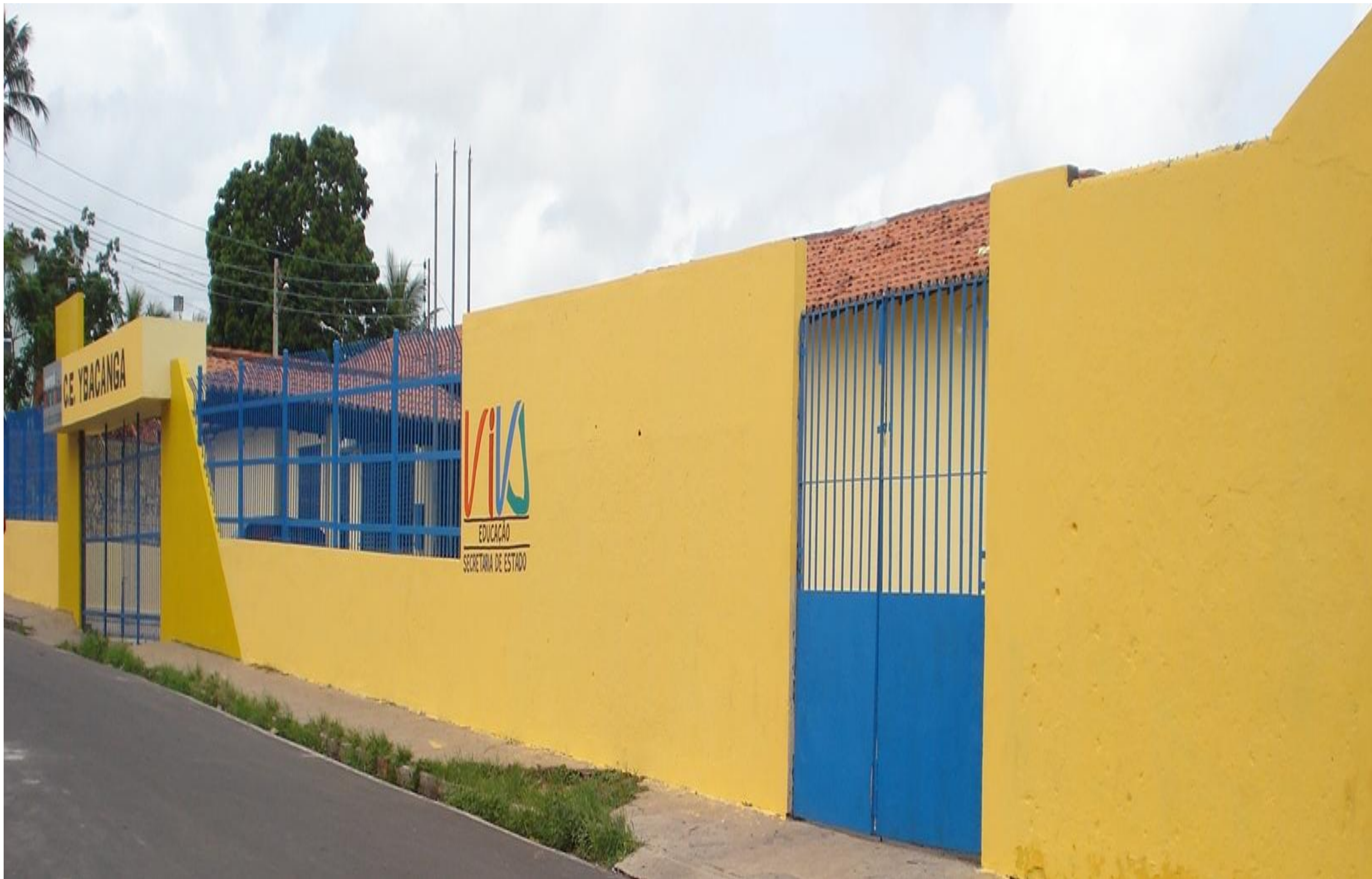
Foto: Fachada da Escola Y Bacanga em São Luís-MA (Autores 2011).
